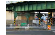
耐震補強工事施工予定箇所
