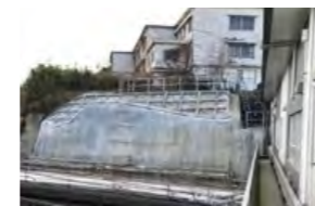
法面防護工事(追浜駅構内上り線側)
