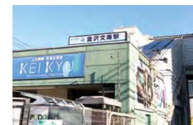
駅施設での太陽光発電設備の設置
