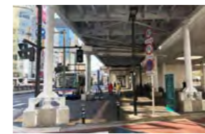
耐震補強工事(京急川崎駅~八丁駅)
