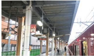
▲小島新田駅ホームの本設上家設置
