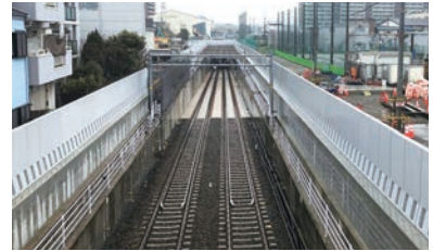
▲トンネル坑口の浸水防止壁の設置
