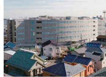
▲金沢文庫現業事務所 外観
