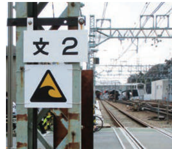
▲津波浸水区間表示板
