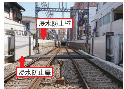
▲大鳥居駅トンネル入口(京急蒲田方)
