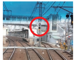
▲神奈川新町第1踏切道(下り線)に対する発光信号機の増設
